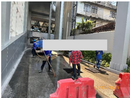
รูปที่ 2-7 การฉีดพรมน้ำและทำความสะอาด ภายในพื้นที่ก่อสร้างเพื่อลดฝุ่นละออง
