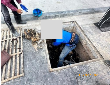
รูปที่ 2-25 การลอกวางระบายน้ำและบ่อดักตะกอน
