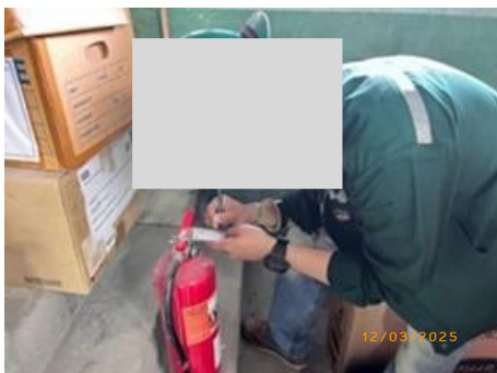
รูปที่ 2-29 การตรวจสอบถังดับเพลิง ให้อยู่ในสภาพพร้อมใช้งาน
